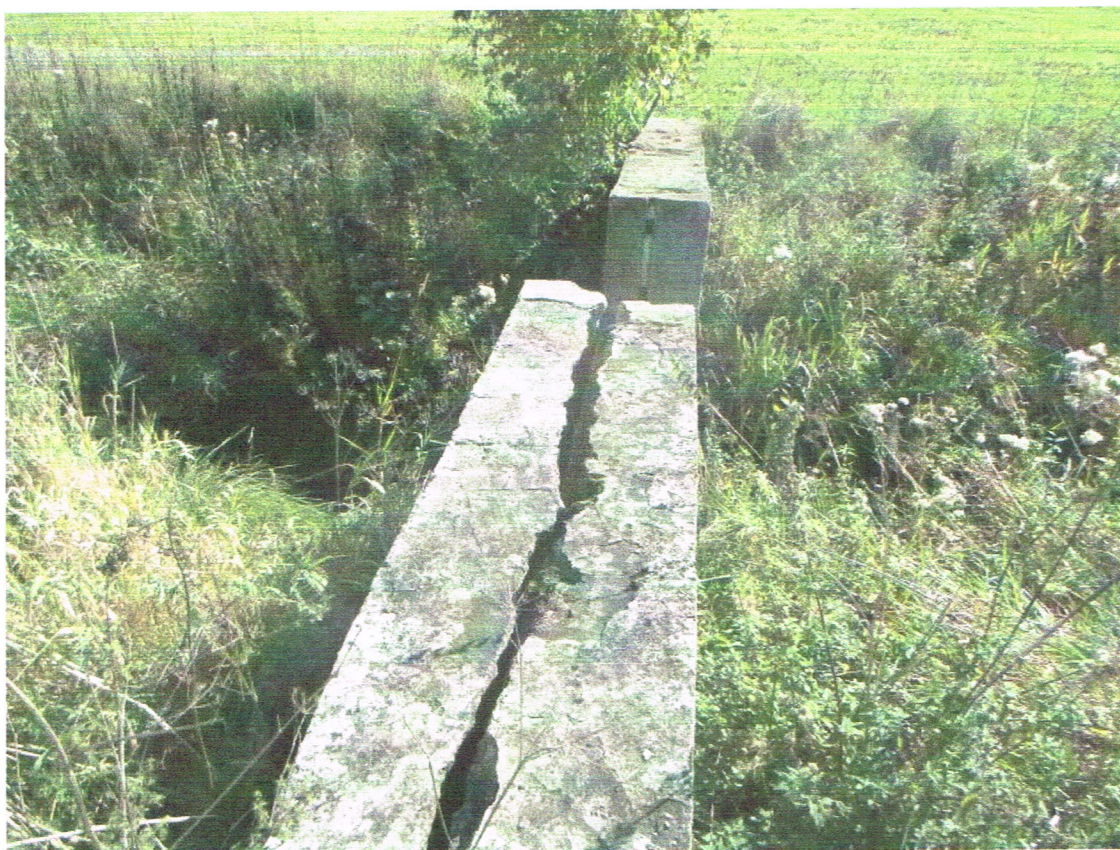
Fot. nr 3. Zastawka na rzece Filipince w km 2+076.
